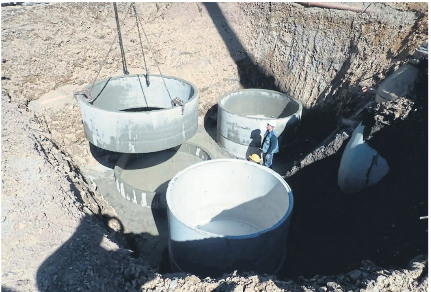
Stück für Stück wurden die vorgefertigten Teile am gestrigen Dienstag in der Baugrube zusammengefügt.
