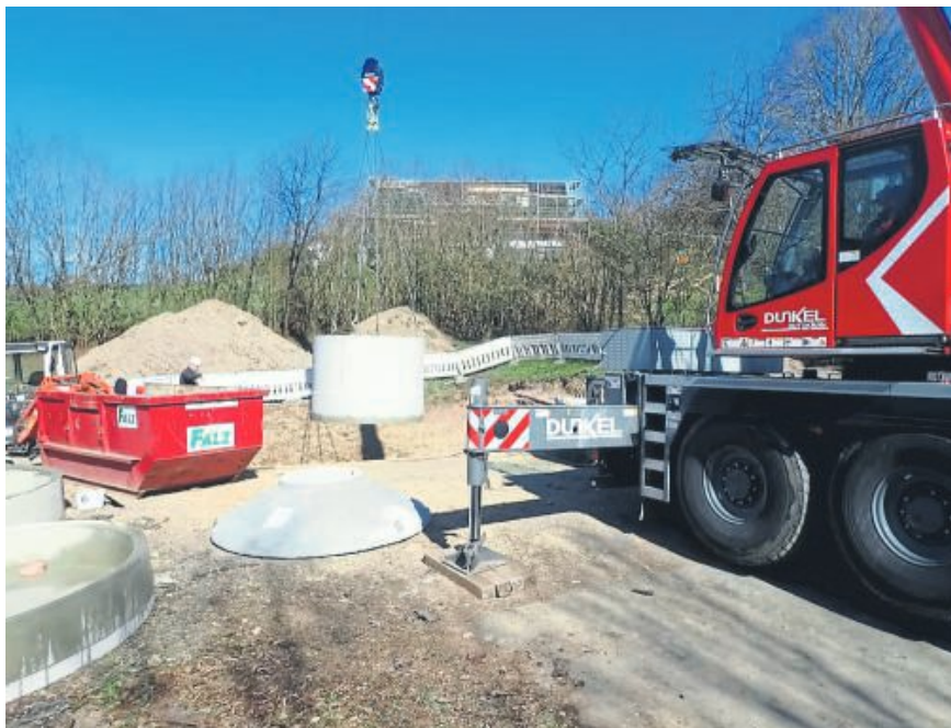
Um die Baugrube herum war es sehr eng, dadurch wurde die Bewegungsfreiheit des Krans stark eingeschränkt.
