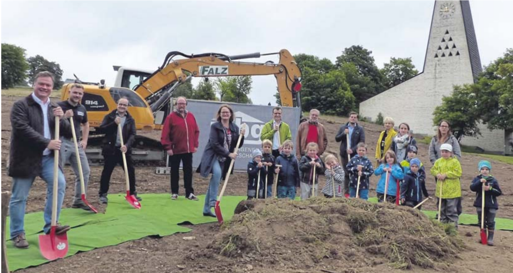
Spatenstich für die neue Awo-Kita Farbenspiel: Bürgermeister Jan Nesselrath (links) freute sich mit Vertretern von Awo, dem Märkischen Kreis, MBG, Bauunternehmen sowie großen und kleinen Gästen der derzeit im Haus Lyck untergebrachten Kita über die nächste Stufe des Projekts. FOTO: F. ZACHARIAS
